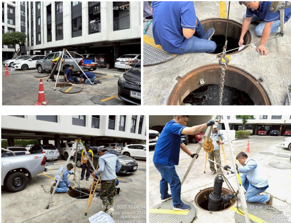
ภาพที่ 3-31 ซ่อมบำรุงระบบบำบัดน้ำเสีย บั้มเติมอากาศที่ชำรุดนำไปซ่อมแซมให้กลับมาใช้งานและระหว่างดำเนินการใช้รวกกัน และดำเนินการในช่วงเวลากลางวัน
