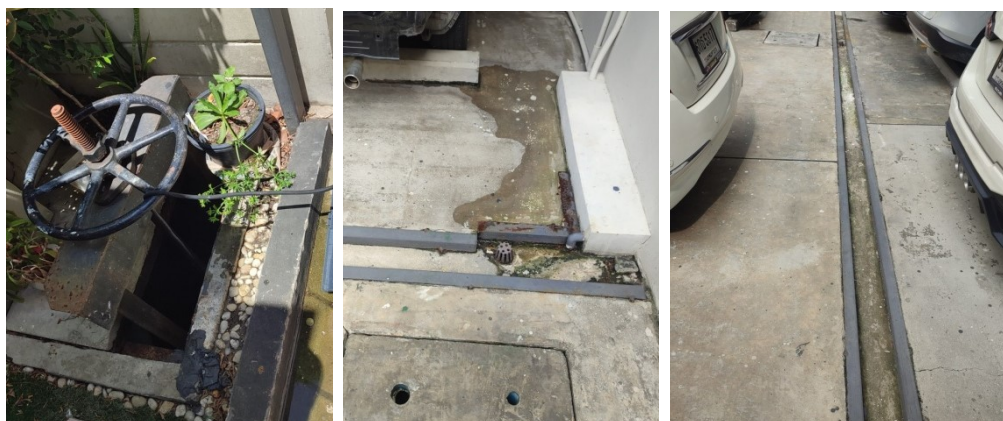
ภาพที่ 3-11 บ่อดักขยะ และบ่อตรวจคุณภาพน้ำมีตะแกรงเหล็กดักขยะภายในบ่อ
