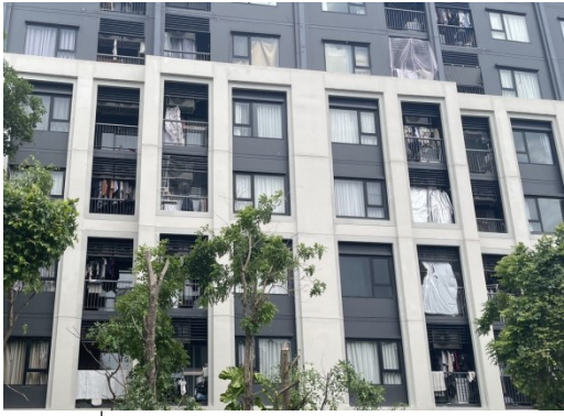
ภาพที่ 3-1 ระจกหน้าต่างประตู ค่าการสะท้อนแสงไม่เกินร้อยละ 30 และเป็นช่องเปิดระบายอากาศของอาคาร
