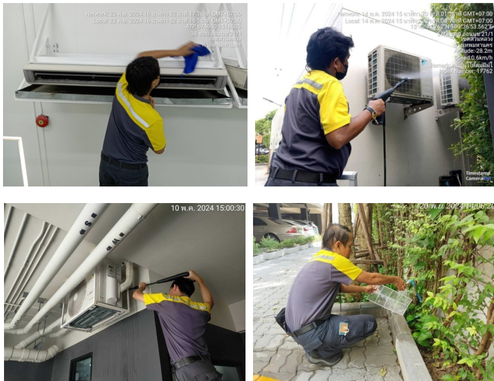
ภาพที่ 3-27 ล้างทำความสะอาดเครื่องปรับอากาศ
